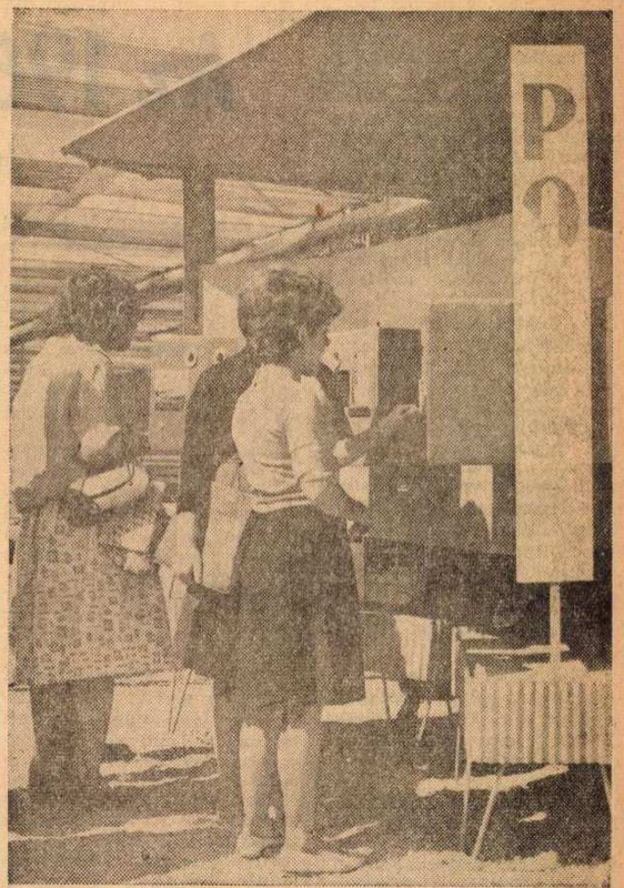
képeslap árusító automatái nagy sikert arattak a Mezőgazdasági Kiállításon.
